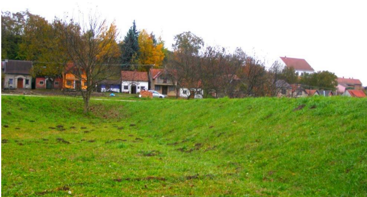
8. ábra Gyepes beszivárogtató teknő (forrás: https://vizmegtartomegoldasok.bm.hu )
