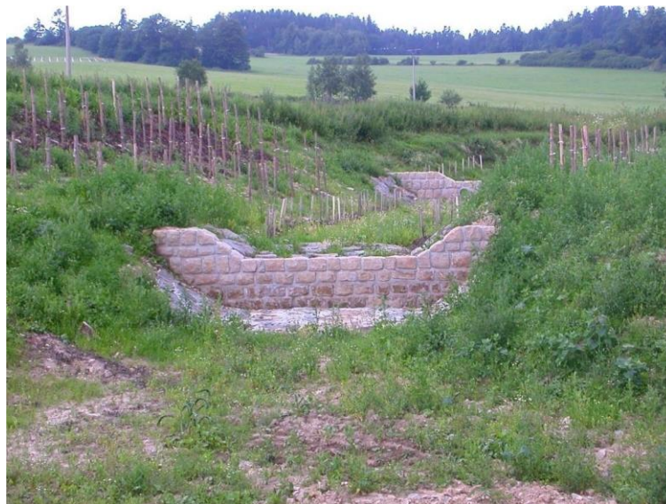
9. ábra Vízmosáskötés gáttal (forrás: https://vizmegtartomegoldasok.bm.hu )
