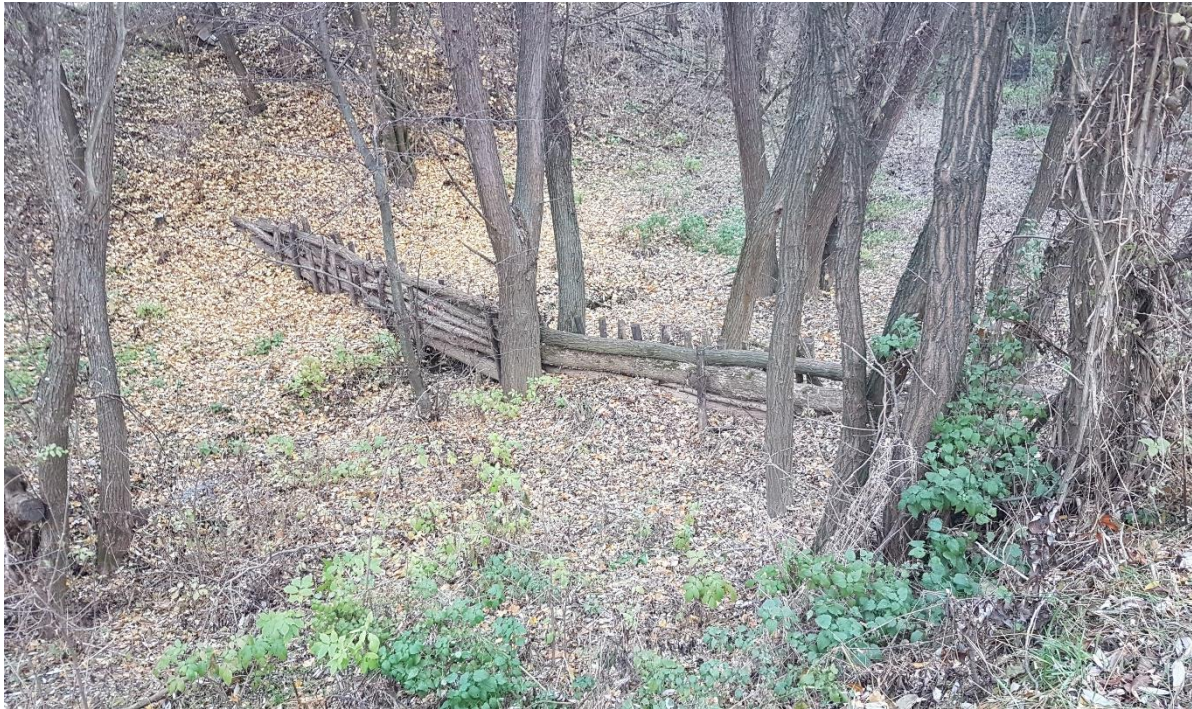
4. ábra Szivárgó rönkgát (szerzők fotói)
