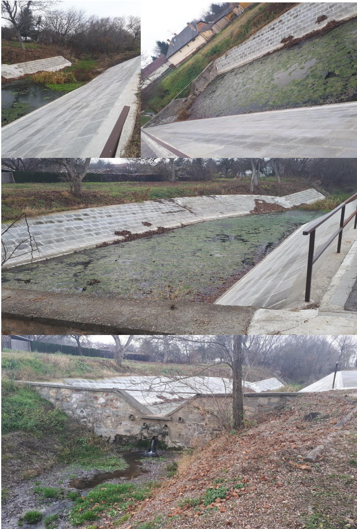
3. ábra Felújított terméskő hordalékfogók (szerzők fotói)
